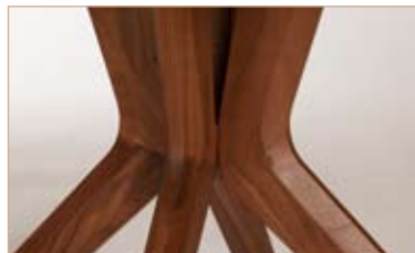
Keilgezinkte Verbindung
